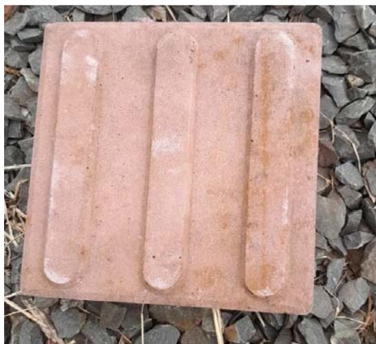
A sinalização tátil no passeio será do tipo de alerta e direcional. Ambas devem ter cor vermelha e devem integradas ao revestimento em paver e não deve haver desnível. A textura da sinalização tátil de alerta consiste em um conjunto de relevos tronco-cônicos conforme tabela e figura a seguir. A modulação do piso deve garantir a continuidade de textura e o padrão de informação.
